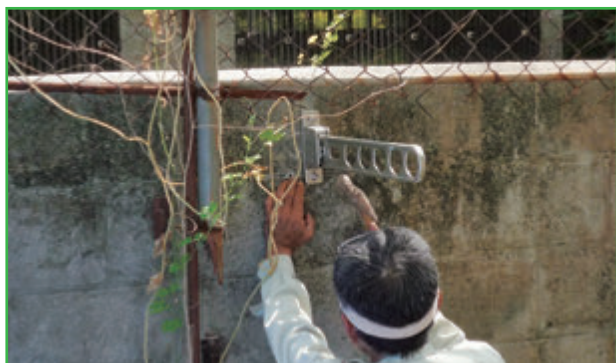
▲庭の洗濯物干し縁台の取付け。
